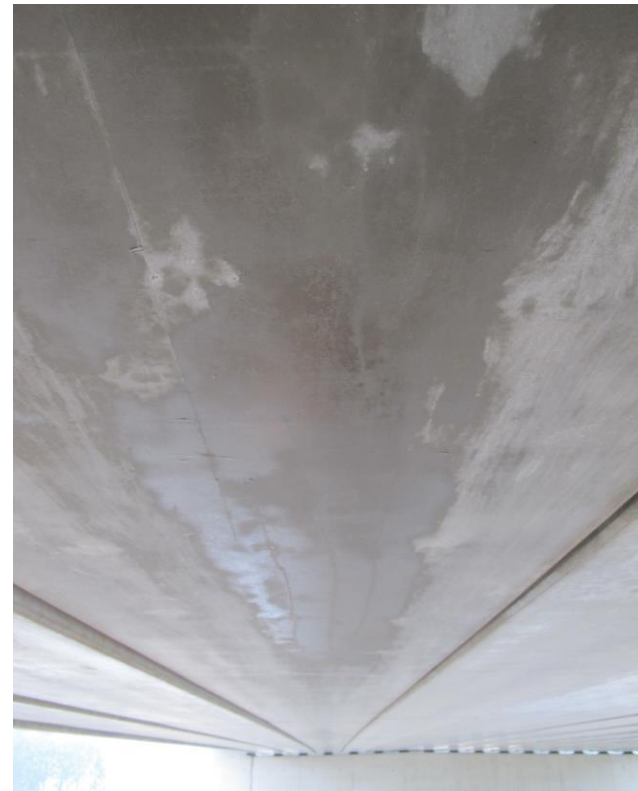
Langsscheuren in onderzijde balken
