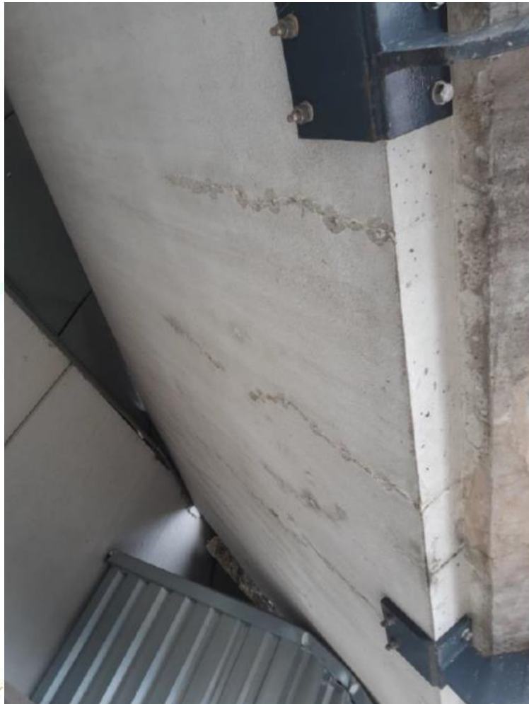
Figuur 16: In het verleden uitgevoerde herstelwerkzaamheden aan bezwaken tribune-element.
